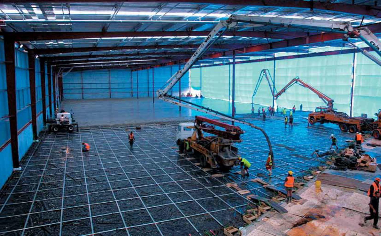
El diseño de las estructuras de losas postesadas requiere de un estudio de ingeniería exhaustivo para maximizar los beneficios para todas las partes interesadas:
